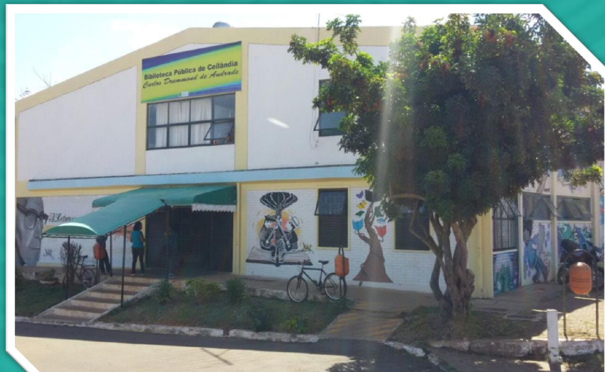
Revitalização do prédio
